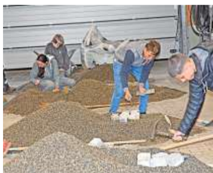
Im Gartenbaubetrieb A. Meier Gartenbau AG versuchten sich die Schüler an einer Bogenpflasterung mit Natursteinen. BILDER: ALFRED WEIGEL
